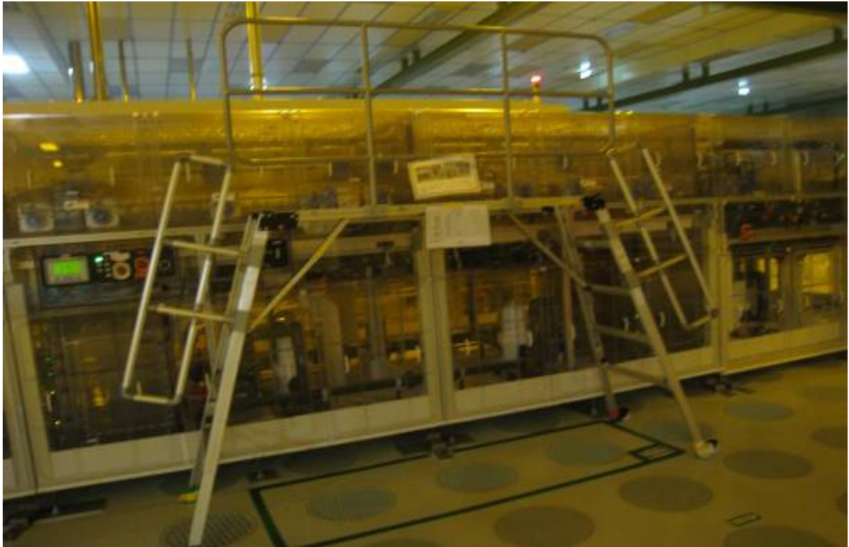
6. 移動式工作臺提供扶手、護欄，可為泥作、油漆及裝修等作業使用之照片。
