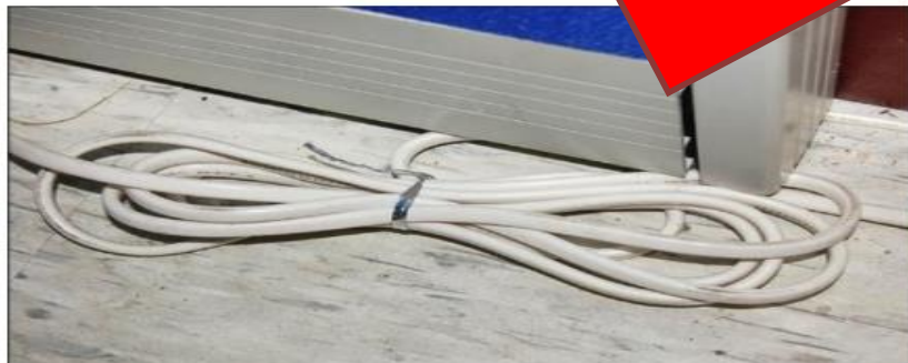
延長線擠壓造成變形
