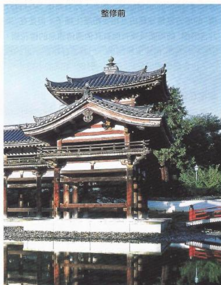
平等院鳳凰堂整修前及整修後
