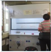
圖5. 抽風櫃保養後未測保養性能(如 風速及噪音值...等)。
