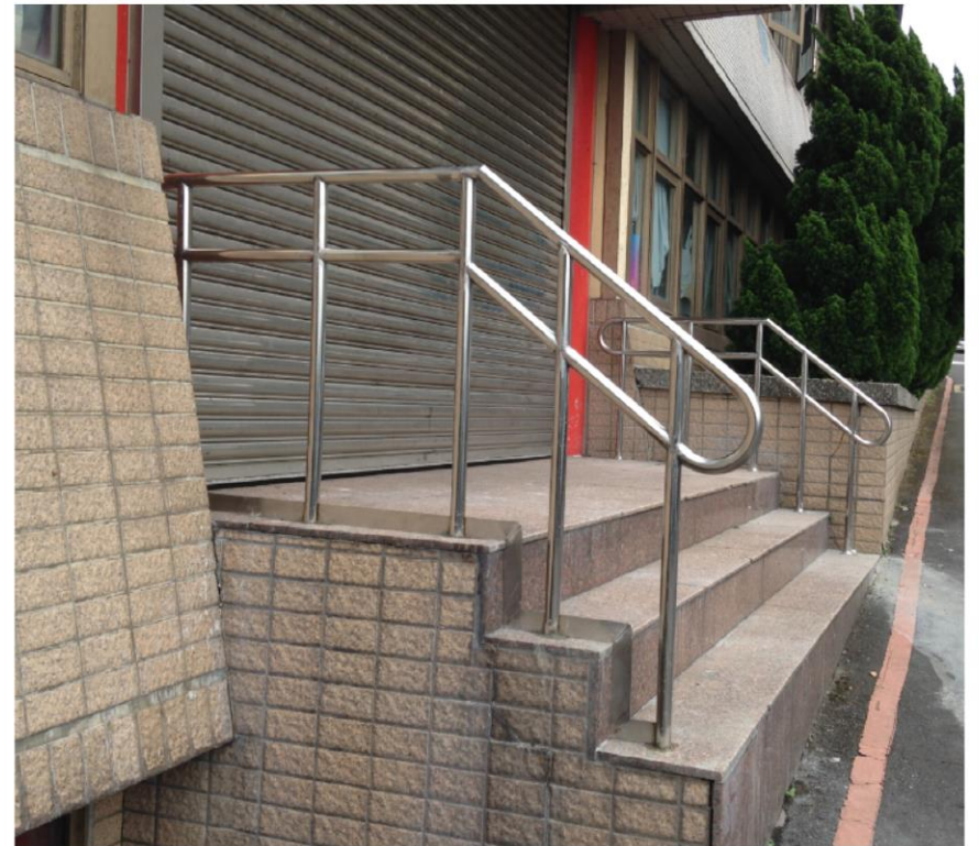
改善後設置安全護欄
